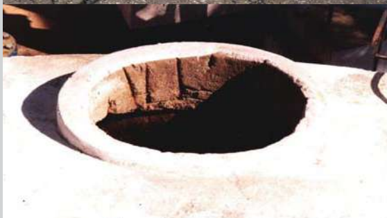
Figura 18 - Não-conformidades de segurança sanitária de reservatórios
