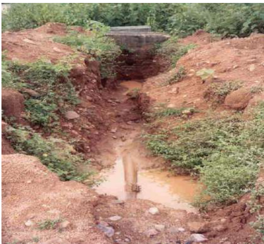
Figura 12 - Vazamento em adutora
