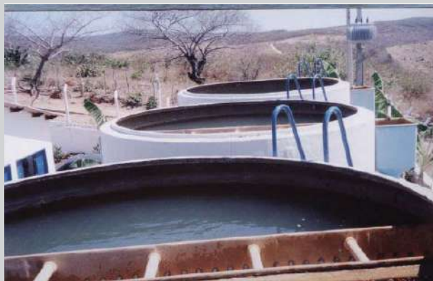
Figura 14 - Filtros de fluxo ascendente sem tampa
