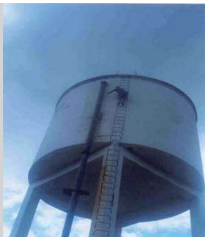
Figura 17 - Reservatórios com escada sem gaiola de proteção
