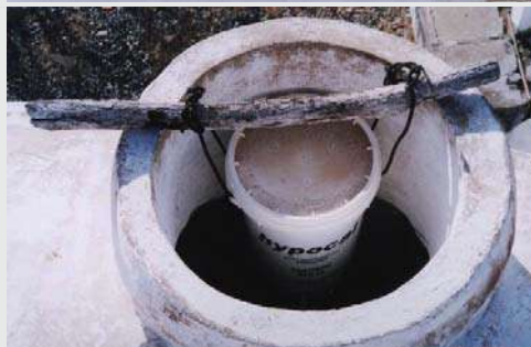
Figura 18 - Não-conformidades de segurança sanitária de reservatórios
