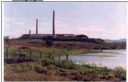
Foto 1 – Fábrica de cerâmica instalada às margens do manancial de captação
