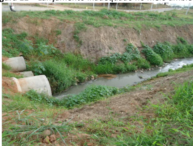
Figura 11 – Lançamento inadequado no meio ambiente
