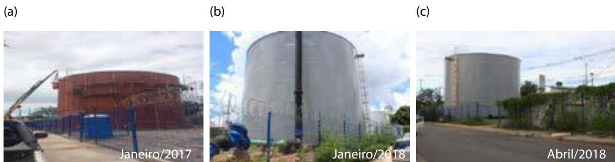
Figura 20 – Implantação Reservatório Bom Clima com capacidade de 1.900 m 3 .
