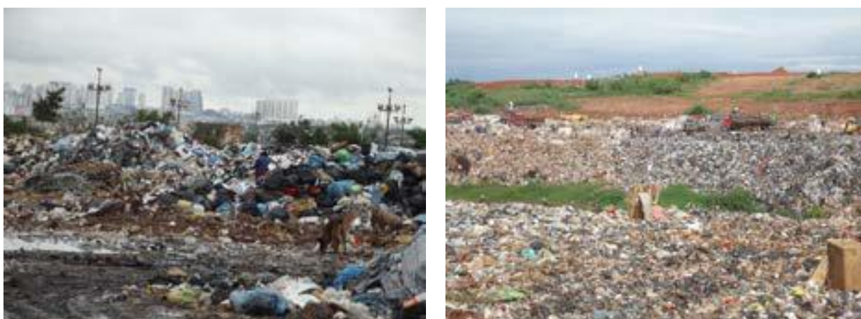
Figura 1 – Imagens do Lixão da Estrutural - Distrito Federal
