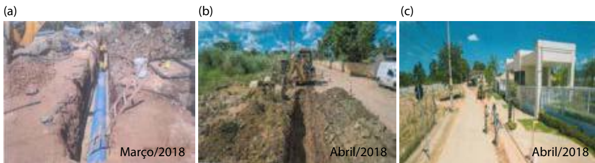
Figura 16 – Implantação das subadutoras (a) RAP Altos do Ribeirão-Booster Maria Tomik - Ø400 mm; (b) RAP Altos do Ribeirão - Rede Despraiado - Ø250 mm e (c) RAP Altos do Ribeirão- Rede Alto da Bela Vista - Ø400 mm.
