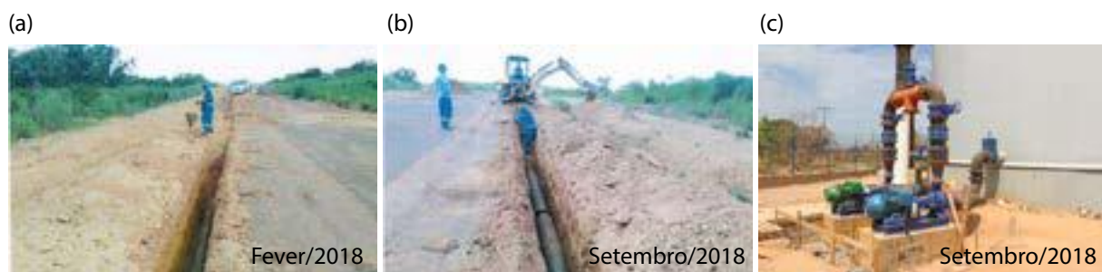
Figura 12 – (a) e (b) Implantação da adutora entre o RAP Altos do Ribeirão-Condôminio Florais, (c) Pressurizadora Linha Florais.
