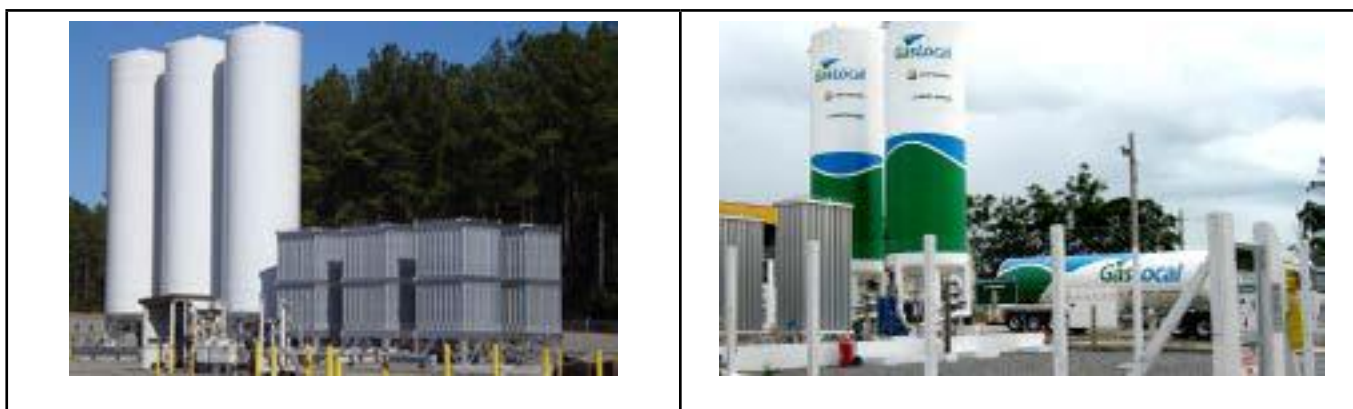
Figura 6 – Regaseificação do GNL
