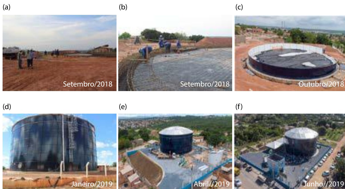
Figura 21 – Implantação Reservatório INPE com capacidade de 4.000 m 3 .
