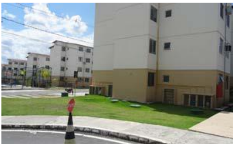
Figura 9 – Instalações prediais de gás – Residencial Total Ville Felicidade
