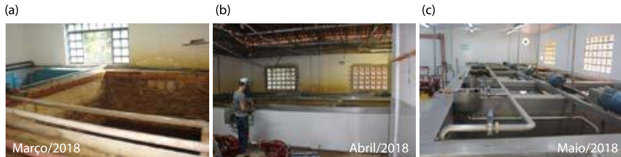
Figura 7 – Reforma casa de química da ETA Ribeirão do Lipa.
