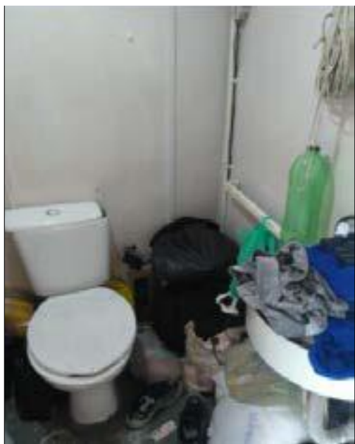
Figura 24 – Sanitário destinado às pessoas com necessidades especiais ou PMR da embarcação E
