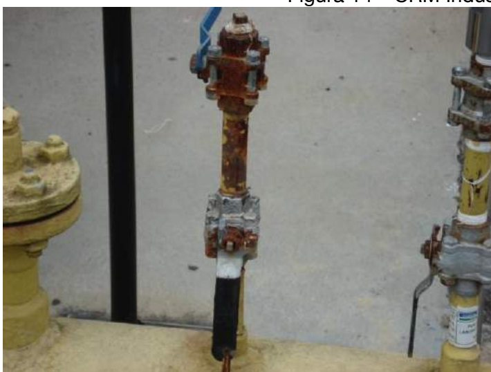
Figura 14 – CRM Industrial Coberto
