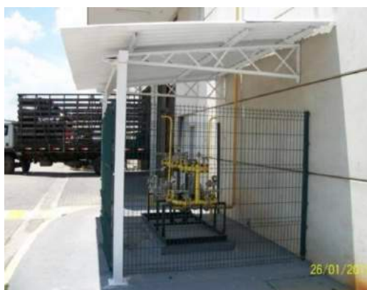
Figuras 09 e 10 – Cobertura e Aterramento Providenciado
