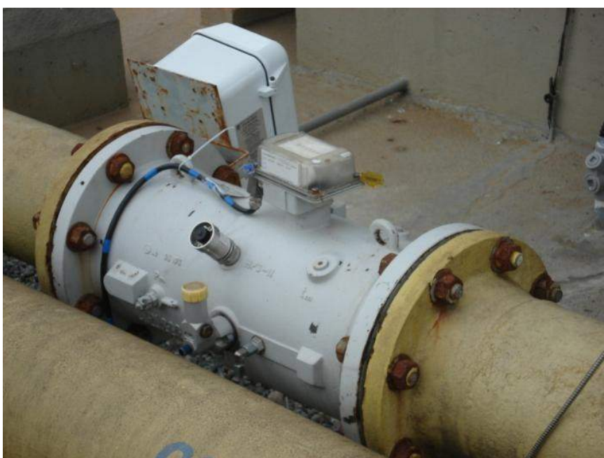
Figura 16 – Componente Oxidados na ETC
