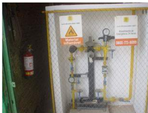
Figuras 06 e 07 – CRM Industrial Após as Benfeitorias
