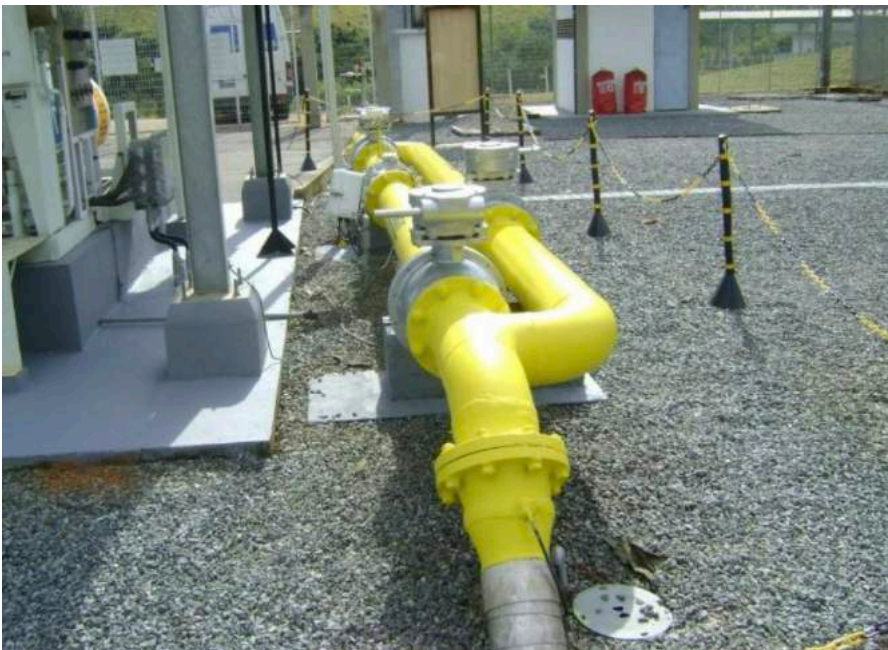
Figura 18 – Substituição de Equipamentos e Nova Pintura
