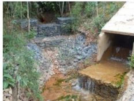
**Foto 1. Parte interna de uma das bacias, com estrutura em gabião que auxilia na filtragem de parte da água lançada.**
