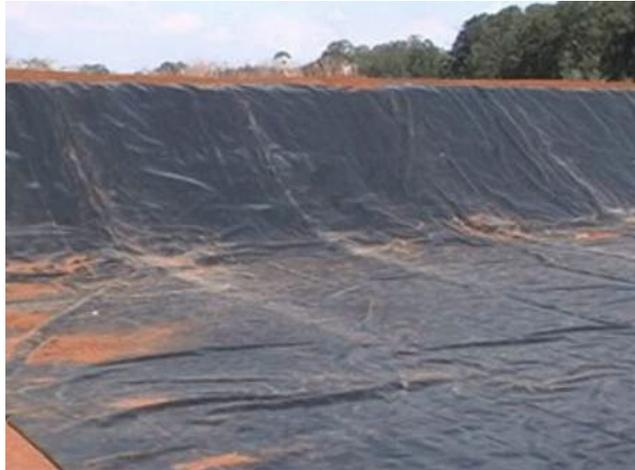
Figura 3: Aterro revestido de manta PVC.
