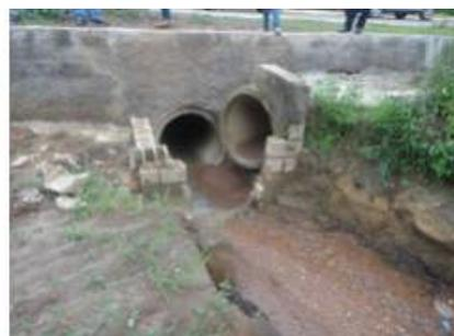
**Foto 3. Formação de erosões pela chegada da água sem nenhum amortecimento e sem preocupação com a proteção do solo.**
