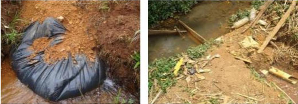
Figura 5. Saco com terra colocado por usuário para impedir o fluxo do canal. Figura 6. Captação sem controle de saída
