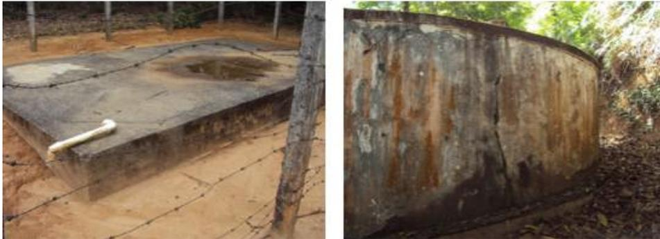
**Figura 3: Área e reservatório em inadequado estado de conservação**
