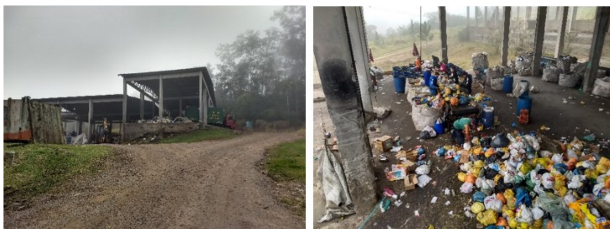
Figura 2 - Área externa e área interna do centro de triagem.
