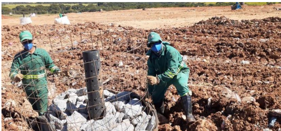
Figura 3 - Funcionários trabalhando com os devidos EPI no Aterro Sanitário de Brasília.
